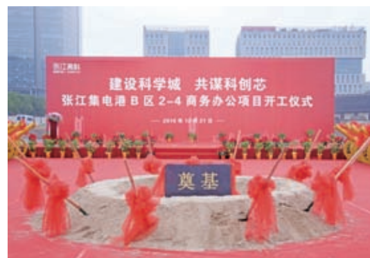
张江高科2-4项目开工
